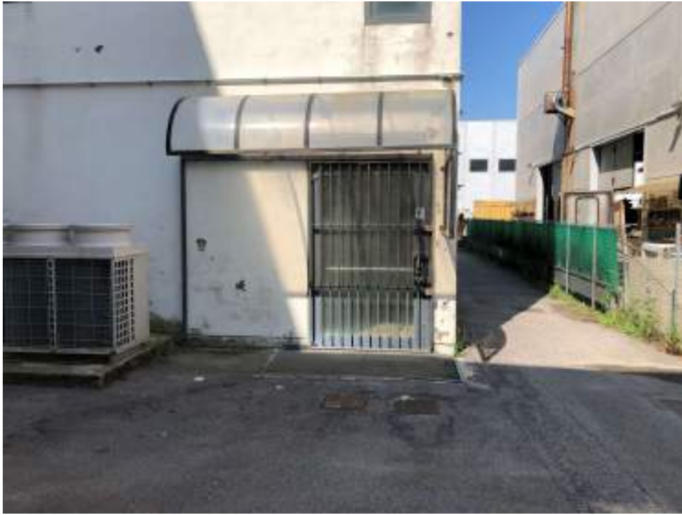
Accessi lato nord
