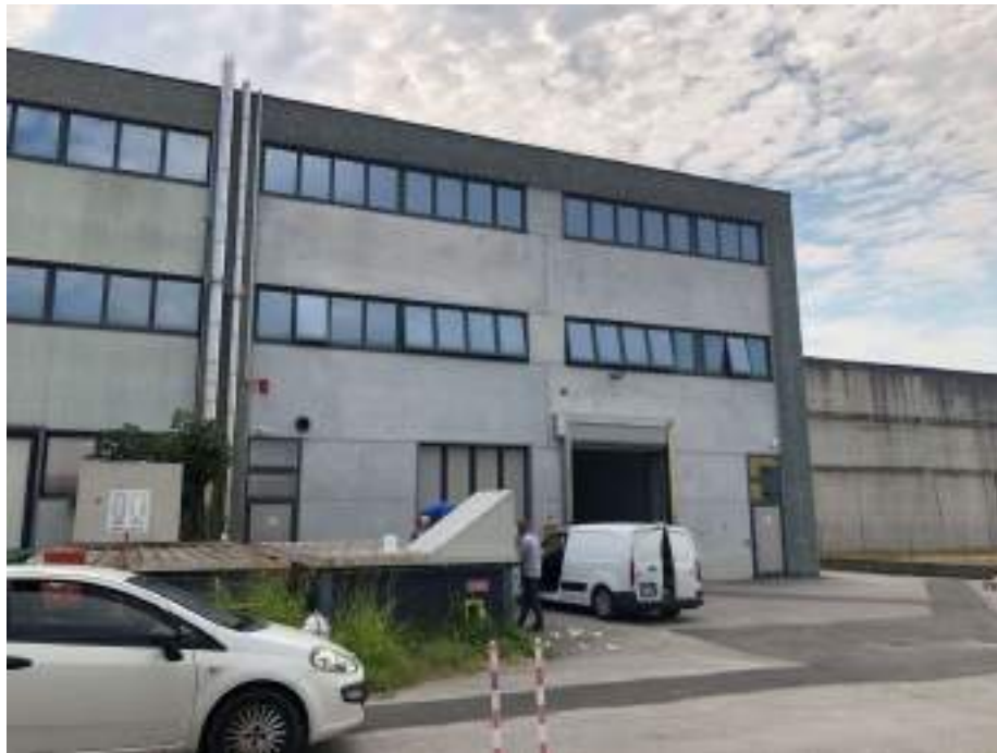
Vista area posteriore con vani tecnici
