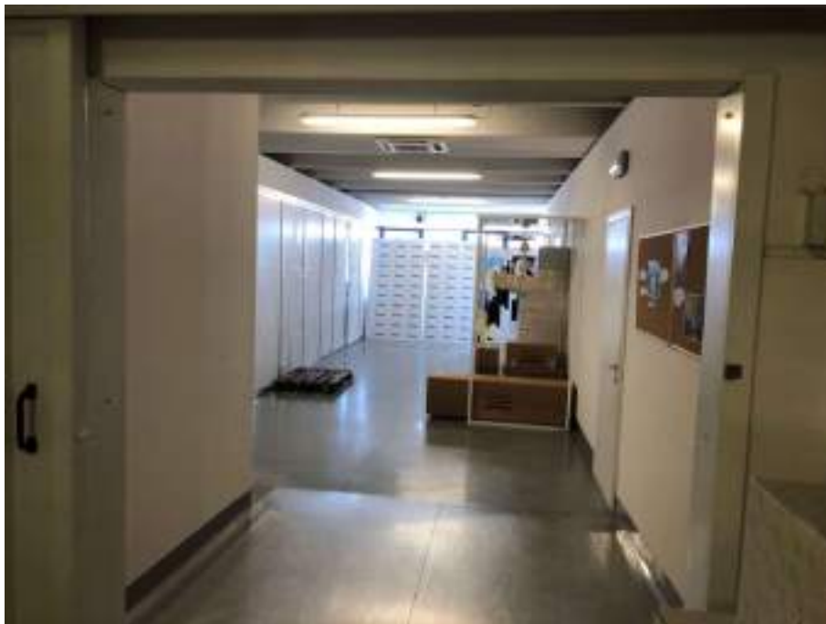
Particolare varco da lotto 1 a lotto 2 piano secondo
