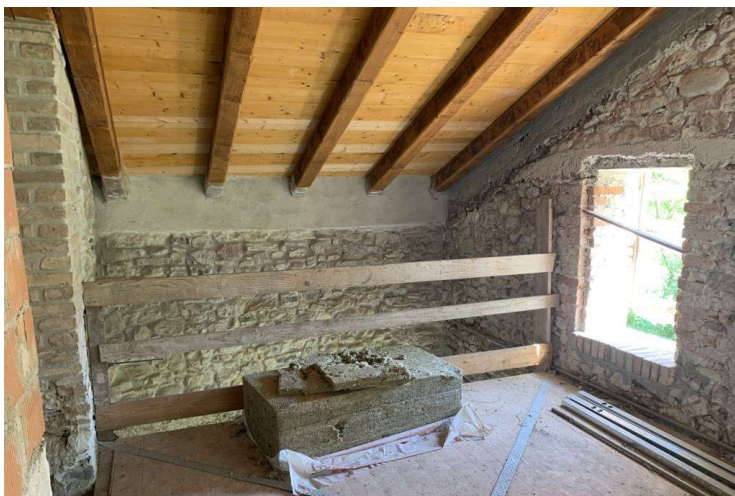
foto n. 11 – locale al piano primo
