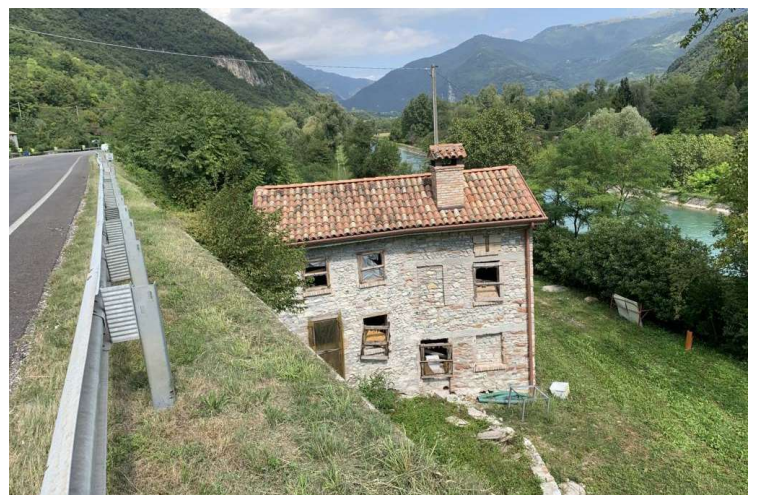
foto n. 6 – vista dell'edificio dalla SR Feltrina
