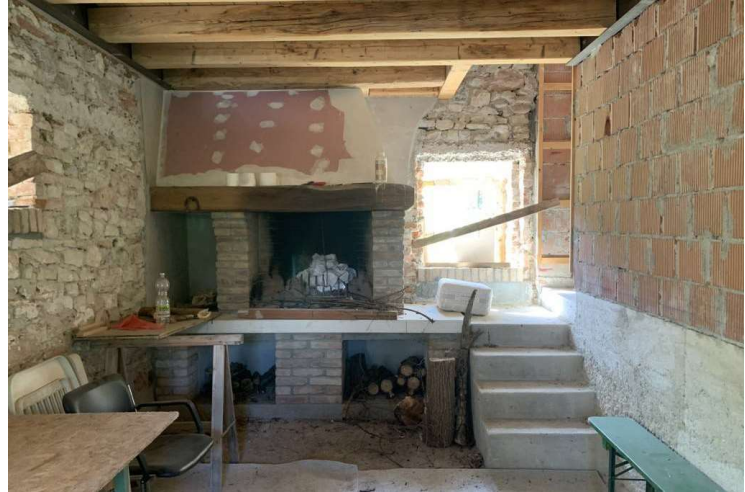
foto n. 8 – caminetto in muratura al PT
