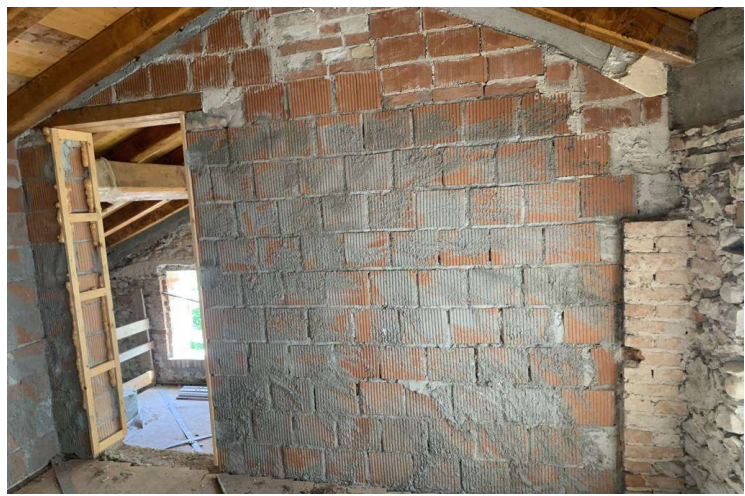
foto n. 12 – locale al piano primo
