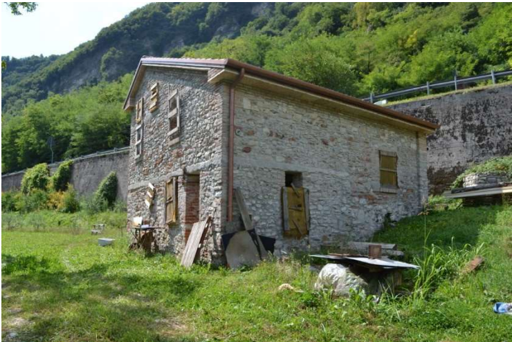
foto n. 3 – prospetti nord ed est
