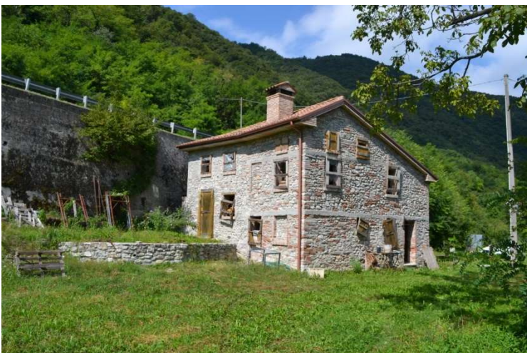
foto n. 5 – prospetti est e sud
