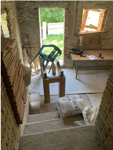
foto n. 9 – vista verso l'ingresso est
