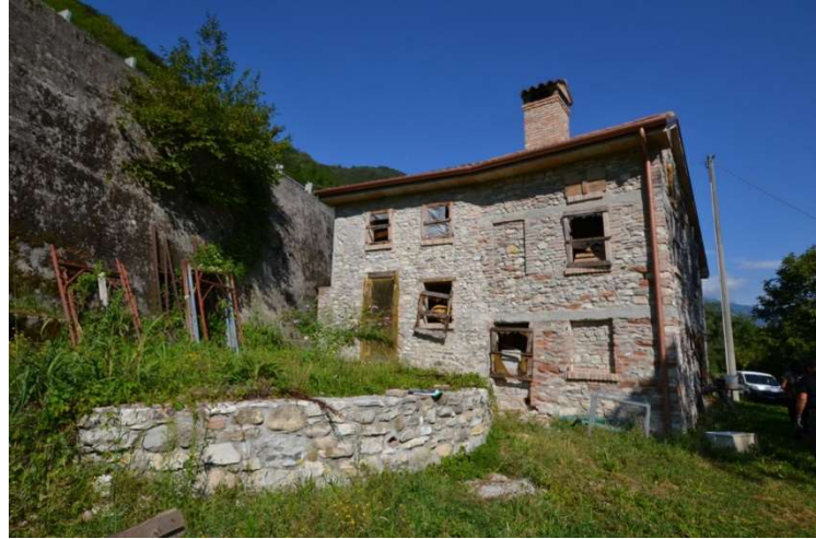
foto n. 2 – edificio prospetto sud e scarpata SR Feltrina
