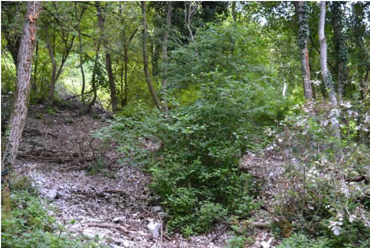
foto n. 3 – confine sud del lotto - frana
