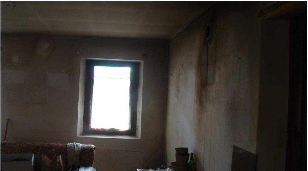
Fotografia 6: le tracce di umidità sulle pareti perimetrali in cucina
